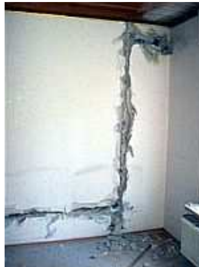
Fig 5 : traces et impacts du passage du courant de foudre sur les canalisations électriques
