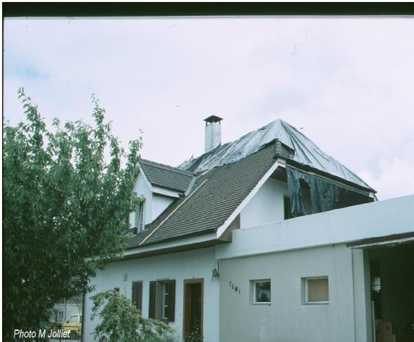
Fig 1 : une partie de la toiture est détruite par l'incendie
