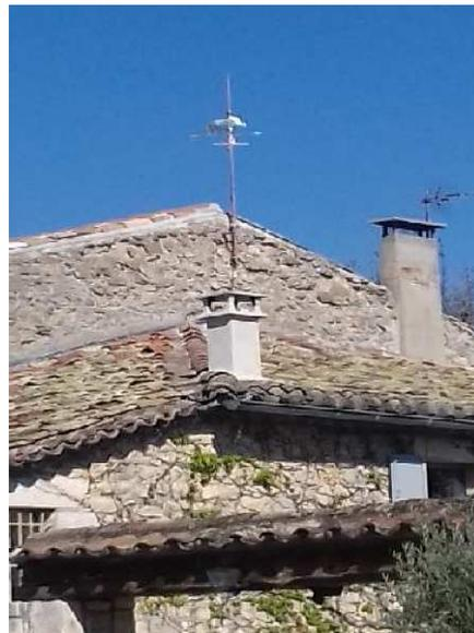
Fig 7: exemple de paratonnerre PDA
