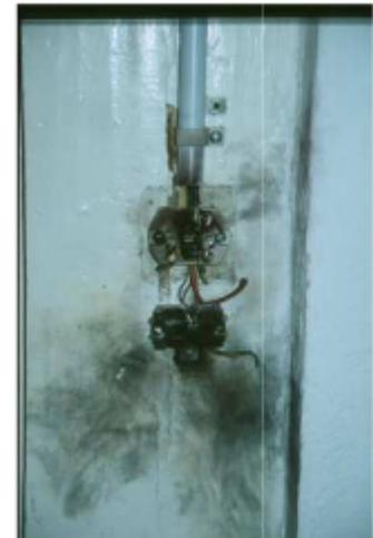
*Fig 4 : prise de courant détruite*
