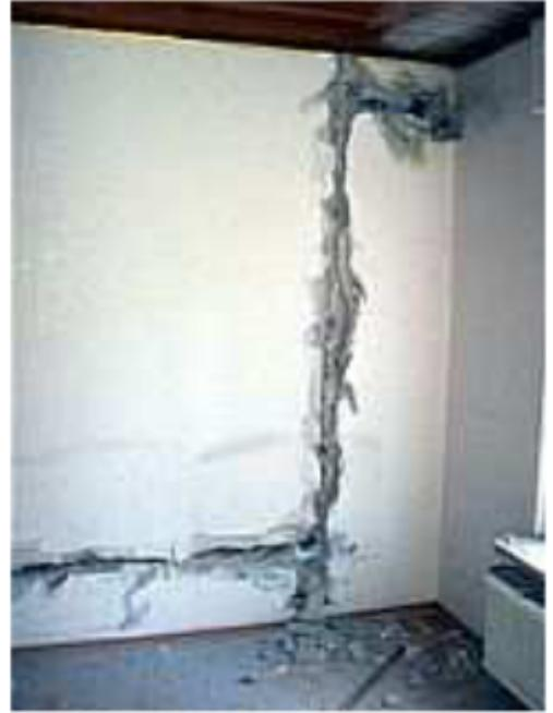
*Fig 5 : traces et impacts du passage du courant de foudre sur les canalisations électriques*
