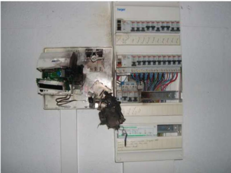
*Fig 6 : disjoncteur principal et compteur détruits*
