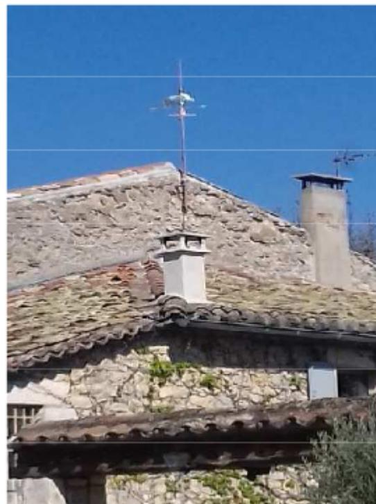
*Fig 7: exemple de paratonnerre PDA*
